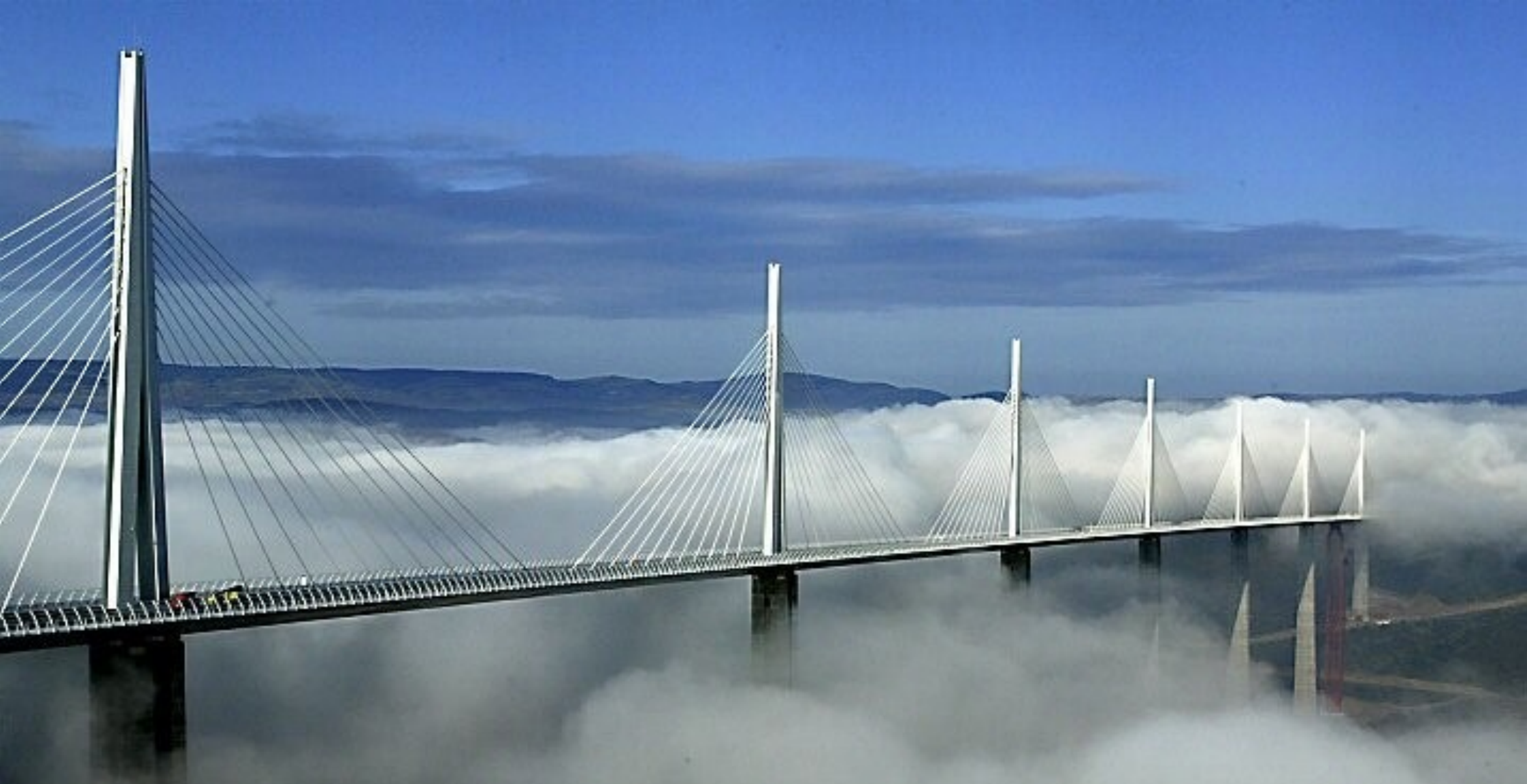
Pont de Millau, Occitanie, France
