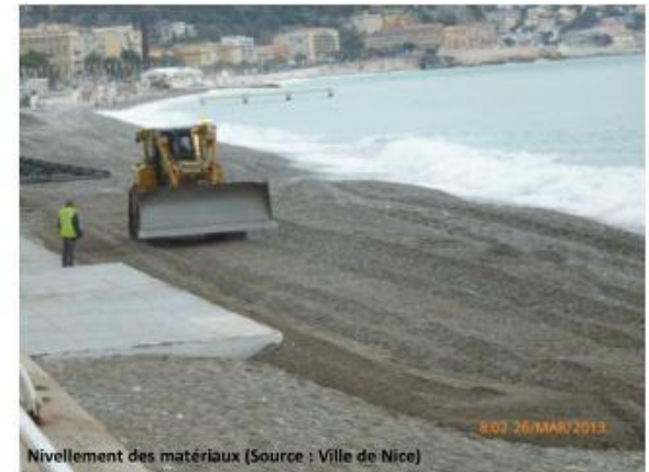
Nivellement des matériaux (Source : Ville de Nice)
