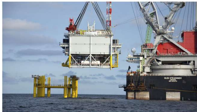
Instalación de la subestación Andalucía, construida en Navantia Puerto Real, en el parque eólico de Wikinger (Alemania). / FABIAN HOPPE / EFE
